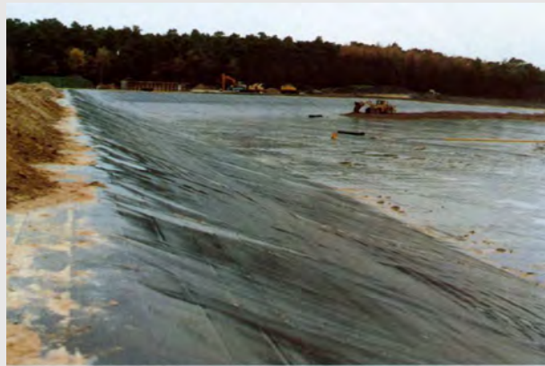
10. Deponie Vechta: Verschweißte HDPE-Dichtungsbahn
