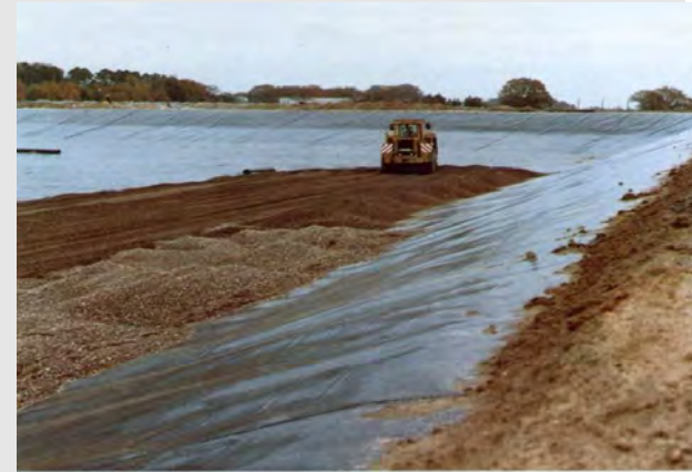
11. Deponie Vechta: Aufbringen der Filterschutzschicht
