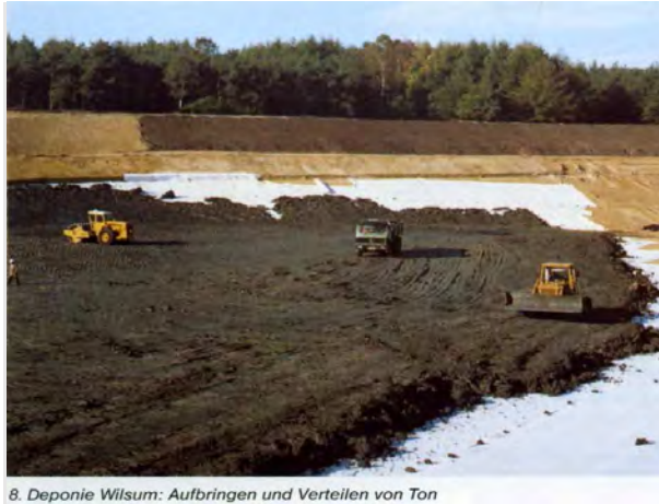
8. Deponie Wilsum: Aufbringen und Verteilen von Ton
