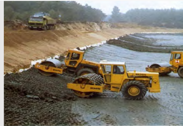
9. Deponie Wilsum: Verdichten des eingebauten Tons
